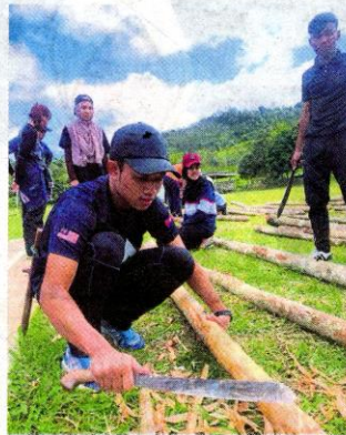
PENYEDIAAN kayu untuk dijadikan tiang lampu solar.
