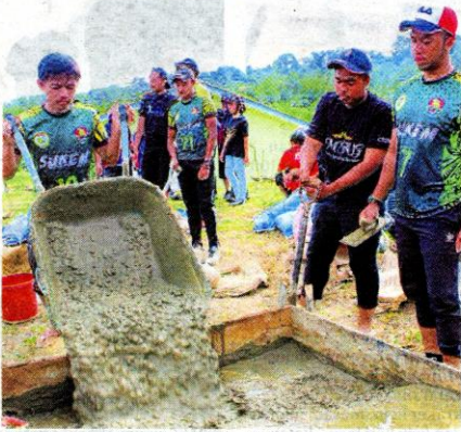
KERJA menyiapkan tapak untuk tangki dan penapis air.
