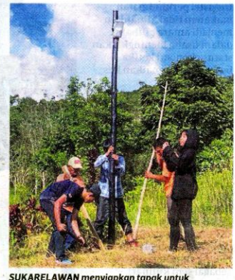
SUKARELAWAN menyiapkan tapak untuk pemasangan tiang lampu solar.
